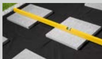
Jetzt Stein- oder Gehwegplatten verlegen. Der Abstand der Platten muss entsprechend dem zukünftigen Abstand der Unterkonstruktion gewählt werden. Bitte kontrollieren Sie nochmals das Gefälle.
