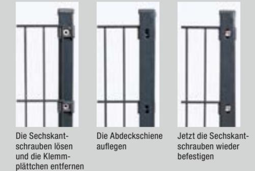
Die Sechskantschrauben lösen und die Klemmplatte entfernen
