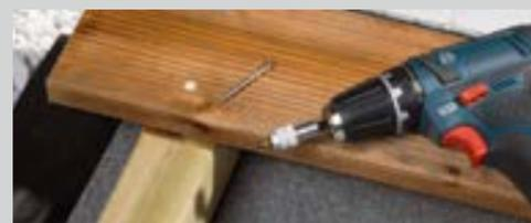
Terrassendielen im rechten Winkel zur Unterkonstruktion ausrichten. Bitte achten Sie auf ausreichend Abstand zu festen Bauteilen wie Wänden. Es sind zwei Verschraubungen je Brettbreite pro Kreuzpunkt mit der Unterkonstruktion erforderlich. Wir empfehlen Ihnen, vor dem Schrauben mit einem Bohrer mit Senker vorzubohren.
