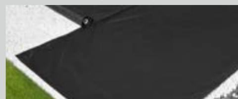
Als ersten Schritt legen Sie eine ebene Fläche an. Anschließend wird eine grobe Schotterschicht (20–40 cm) und eine anschließende Kiesschicht (5 cm) auf der Fläche verdichtet. Bitte beachten Sie, dass die Fläche ein Gefälle von ca. 1–2 % haben muss. Es wird empfohlen, zusätzlich ein Unkrautvlies als Schutz zu verlegen.
