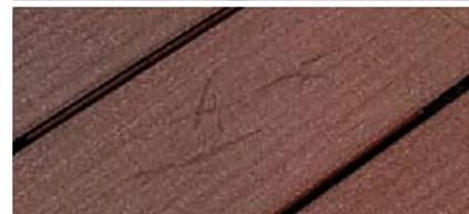
Durch die Nutzung der Terrasse werden Gebrauchsspuren oder „Polierungen“ an der Oberfläche entstehen. Diese gleichen sich mit der Zeit an und verschwinden in der Regel durch die natürliche Bewitterung. Auf regelmäßig gereinigten Terrassen entstehen weniger sichtbare Gebrauchsspuren.
