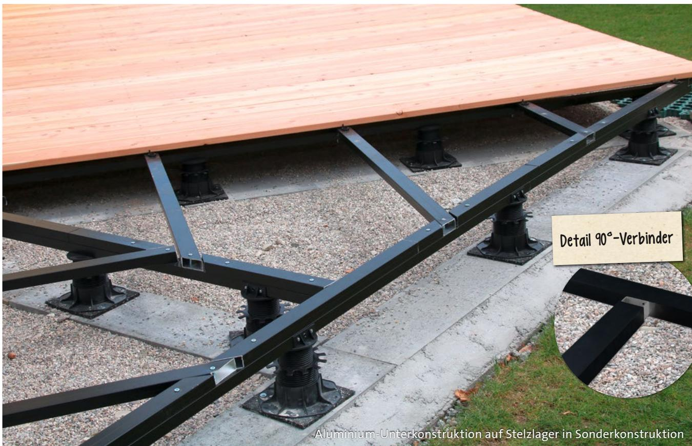
Aluminium-Unterkonstruktion auf Stelzlager in Sonderkonstruktion
