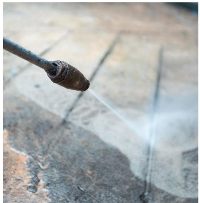
CEDRAL Faserzement-Terrassen lassen sich mit einem Hochdruckreiniger gemäß Anleitung reinigen.
