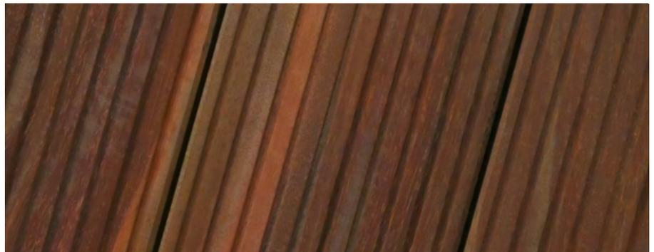
Zur Befestigung dieser Diele empfehlen wir mind. 10er A2-Schlossschrauben, die „versenkt“ mit A2-Unterlegscheiben verschraubt werden sollten.
