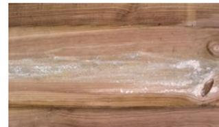
**Salzausblühungen:** Vor allem im ersten Jahr nach der Fertigstellung kann es vereinzelt zu Harzaustritten in dieser Form kommen. Durch die Kesseldruckimprägnierung wird das Harz grün-weiß eingefärbt. Dadurch entstehen kleine Flecken auf der Oberfläche. Die Sonne härtet diese Flecken, so dass diese abgeburstet oder abgewischt werden können. Mit der Zeit verwittern sie von allein und stellen keinen Grund zur Beanstandung dar.
